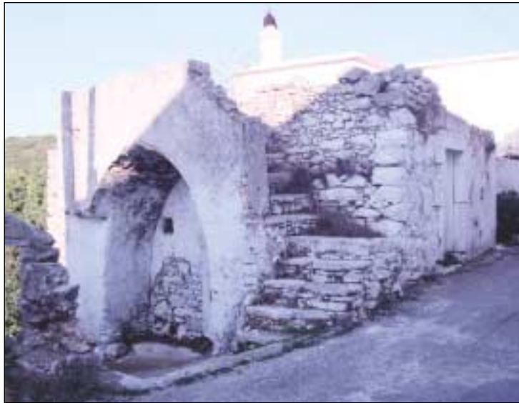
Οι παλιοί μαστόροι ήξεραν καλά τον τρόπο κατασκευής σπιτιών προσαρμοσμένων στις φυσικές συνθήκες κάθε περιοχής.
