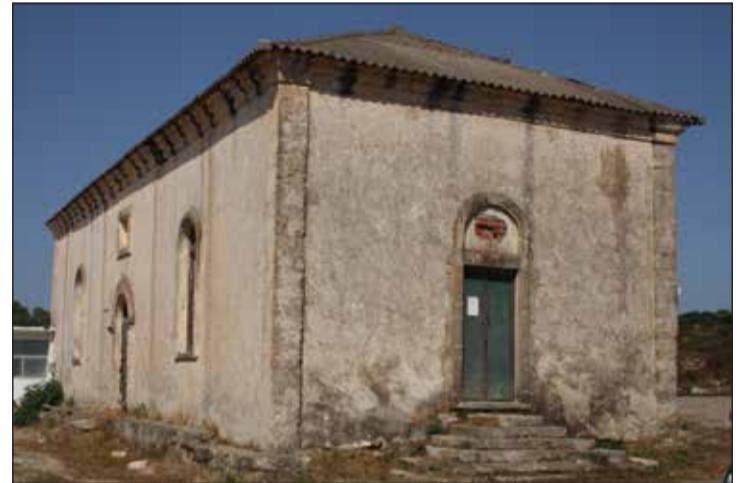
Αστικό Σχολείο Ποταμού, όπως είναι σήμερα. Μάλιστα τέλος Μαΐου άρχισαν οι εργασίες αποκατάστασης του κτηρίου.
