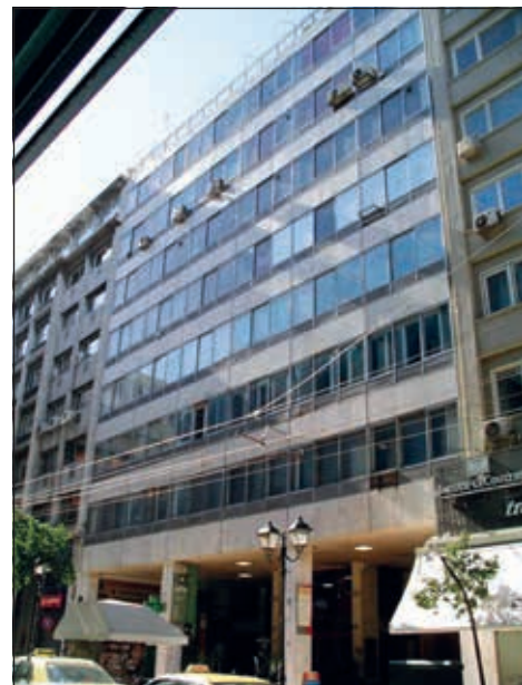
Το κτήριο του Κληροδοτήματος Στάη στην οδό Σταδίου. Το μισό κτήριο στη δεξιά πλευρά, κάθετα, ανήκει στο Κληροδοτήμα.
